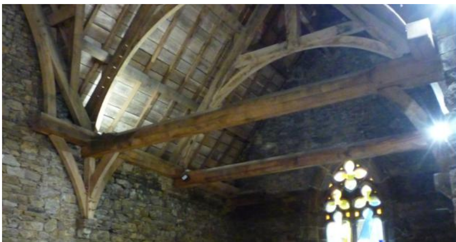
la charpente est remarquable
