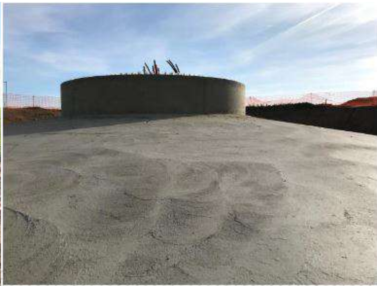
Semelle en béton coulée sur l'armature en ferraille. Source : EDPR
