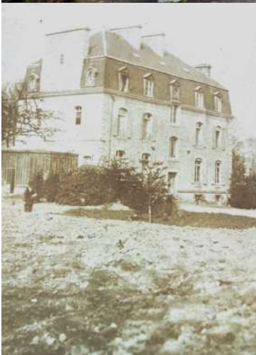
Façade arrière de la villa, donnant sur le parc
